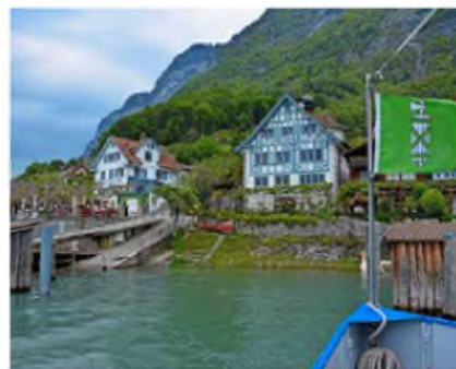
Renovation der alten Post: Pro Quinten hat die Erneuerung der Fassade finanziell tatkräftig unterstützt.
